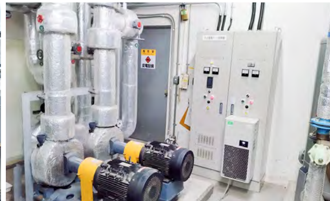
滋賀プロダクトサプライセンター 冷水バックアップ循環ポンプ
