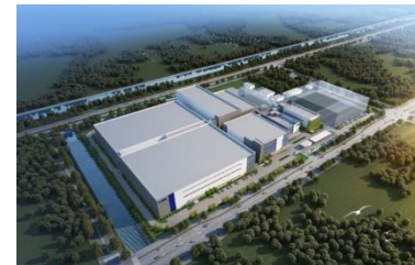
蘇州新工場(建設中)
