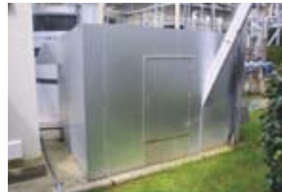
防音対策がほどこされた排水処理装置
