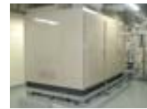
コージェネレーション設備
