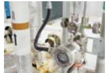
冷却ポンプの差圧制御による省エネルギー(能登工場)
