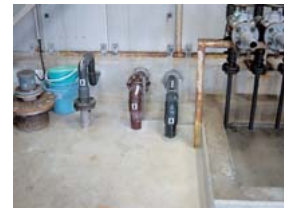
汚泥リサイクル化配管工事
