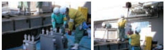
PCBの搬出作業
