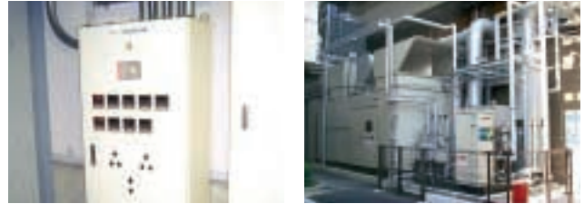
空調自動制御盤（奈良研究開発センター） コージェネシステム（大阪工場）
