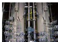
イオン交換処理装置
