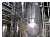
製造用水タンク
